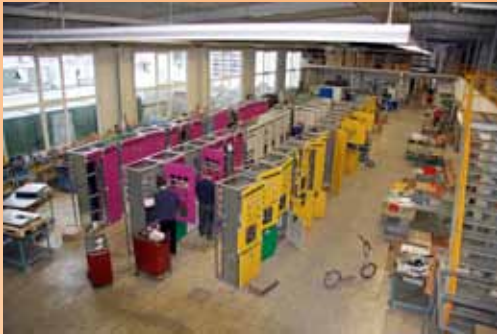
Montagehalle 1 - Fertigung Niederspannungsschaltanlagen
